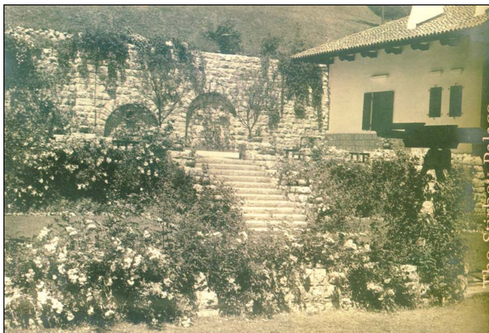
figura 8 Fațada vest, zidul de sprijin și grădina, în perioada interbelică. 5
