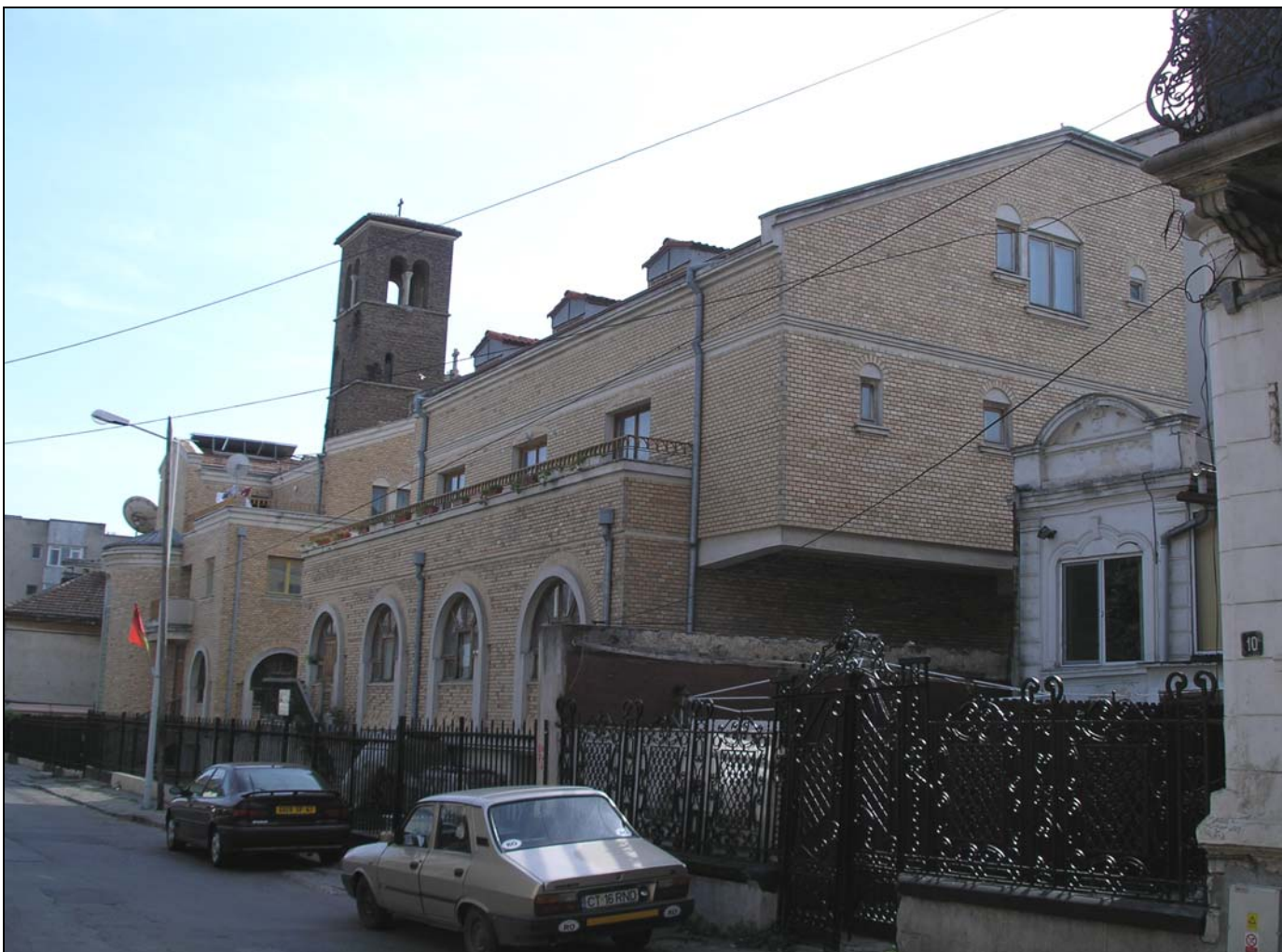
figura 24 Biserica romano-catolică din Constanța –extindere realizată la sfârșitul secolului XX 10 .
